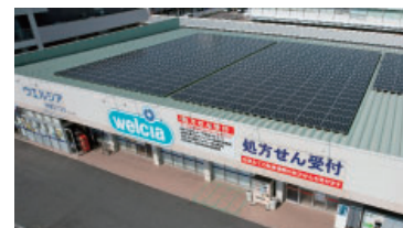
太陽光発電パネルを設置した店舗
