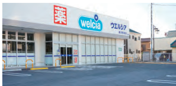
ニュートラック5000を採用したウエルシア藤沢用田店
